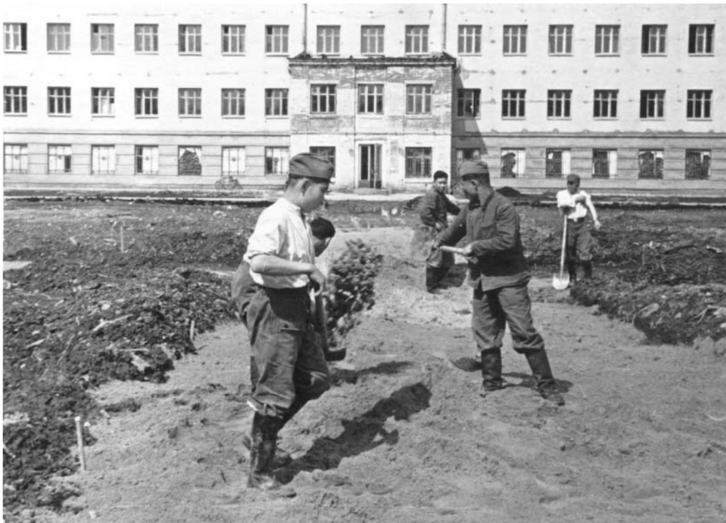
Главспецстрой на корпусе № 1
