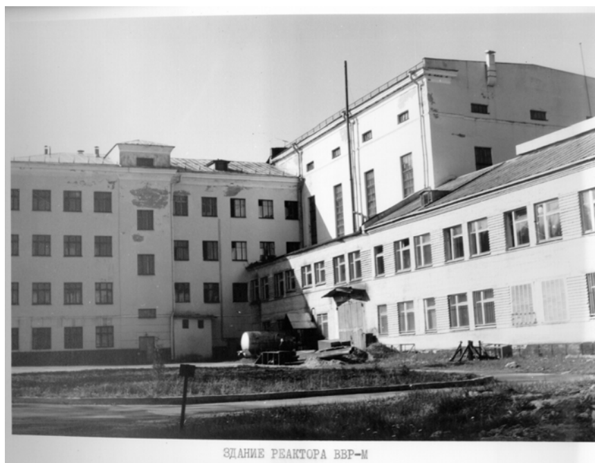
Вид здания реактора ВВР-М с северо-восточной стороны
