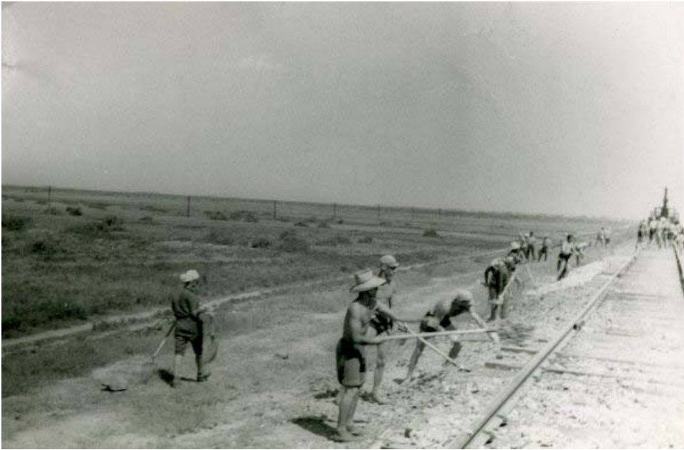
06. Равномерно разбрасываем балласт на путь.
