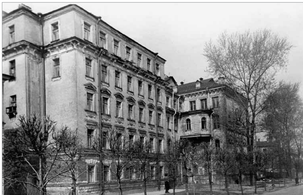
Старое здание НИФИ (1971)
